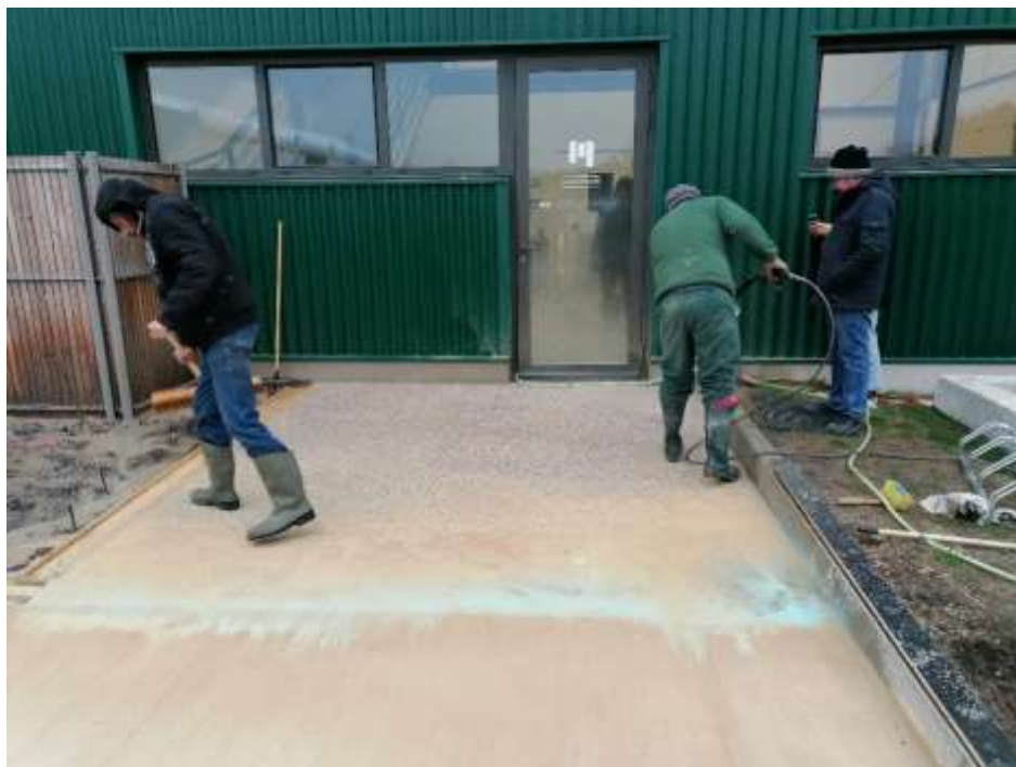
Coulage béton désactivé d'environ 2 \times 10 \text{ m}^2
