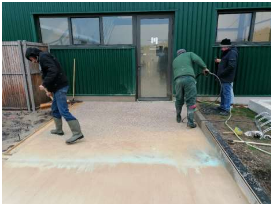
Coulage béton désactivé d'environ 2 x 10 m 2
