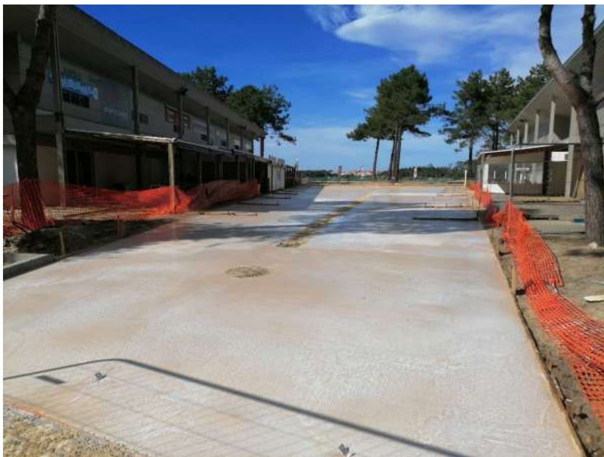
Coulage au camion pompe d'une place : environ 1000 m 2
