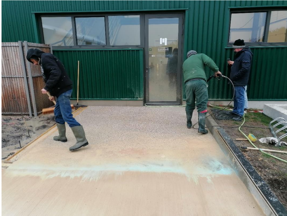
Coulage béton désactivé d'environ 2 x 10 m 2
