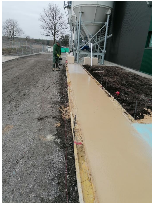
Coulage allée piétonne d'environ 50 m de long
