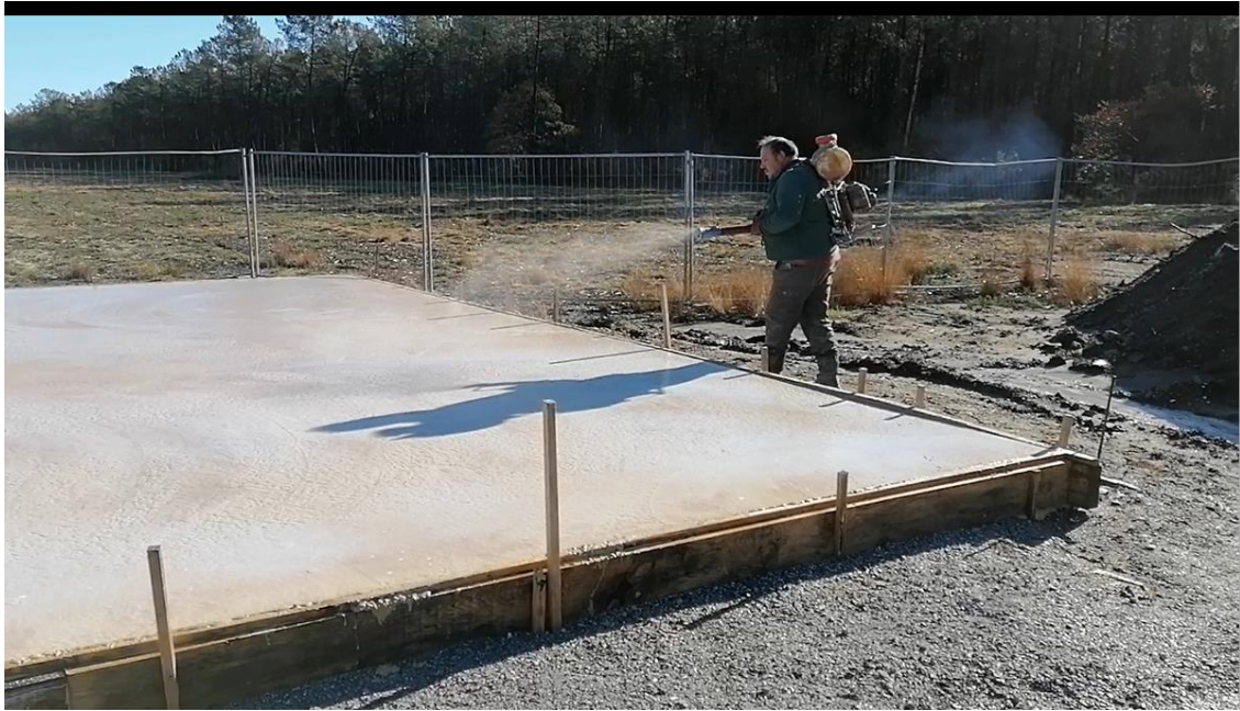
Coulage au camion pompe de deux dalles : environ 200 et 100 m 2
