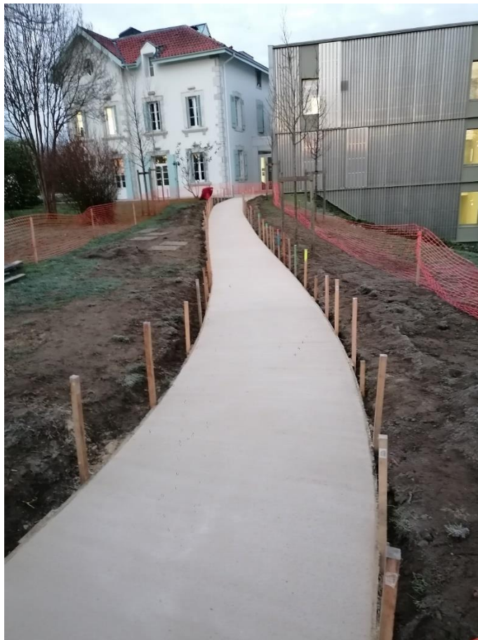
Coulage de l'allée : environ 100 m de longueur
